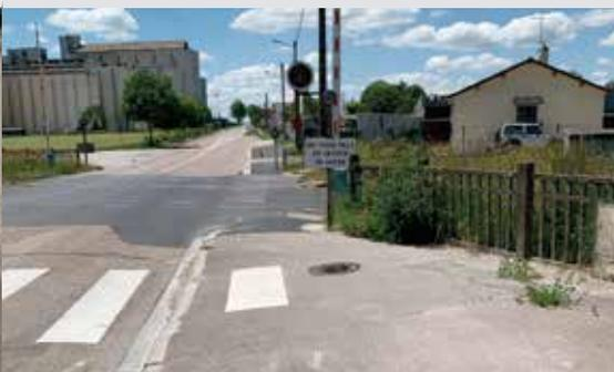
◀ Création d'un chemin en enrobé pour les piétons du passage à niveau côté du centre de secours. Reste à poser les balises de protection et le marquage au sol.
